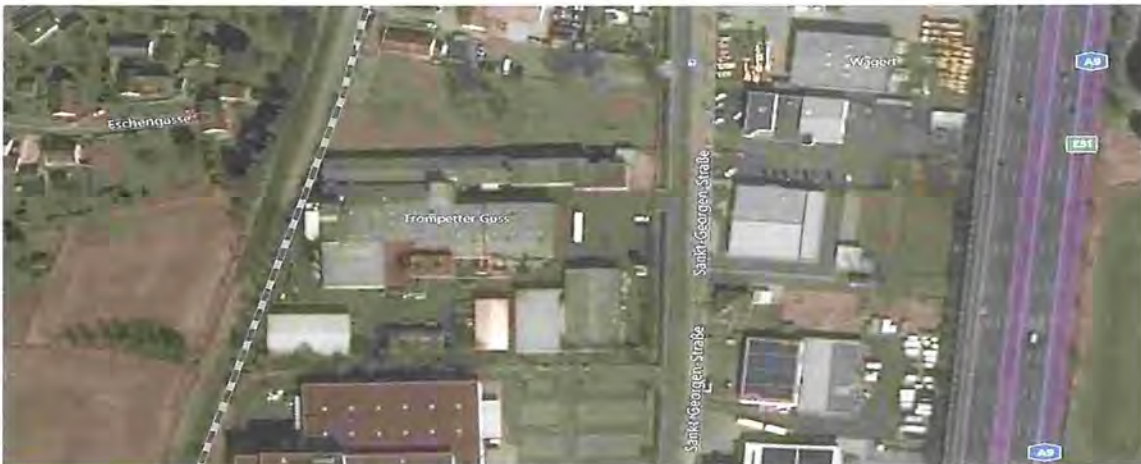
Abbildung 2: Luftbild der Trompetter Guss GmbH mit umgebender Bebauung
